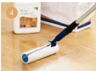
4 水性トップコートを2回以上塗布してフローリングを保護します。
