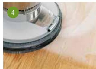
4 BonaダイヤモンドディスクG240でフロア表面を研磨します。
