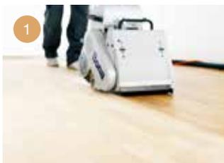
1 木を素地まで研磨します。ペーパーの番手を3回以上変えながら研磨して、表面を平滑に仕上げます。
